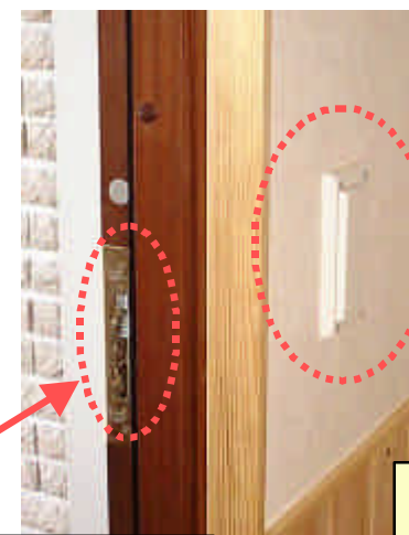
スイッチストライク内蔵 :カギ を掛けるとエルボースイッチ がキャンセルされます。
